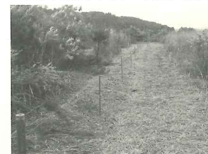
④打込んだ支柱に塩化ビニールパイプを金具で固定し、塩化ビニールパイプの中にポリワイヤーを通して完了。
