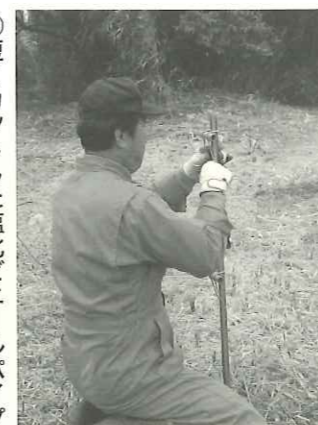
③短くカットした塩化ビニールパイプを金具を用いて支柱へ固定。
