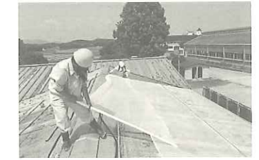
種の流出と乾燥防止のため分解性不織布で覆う
