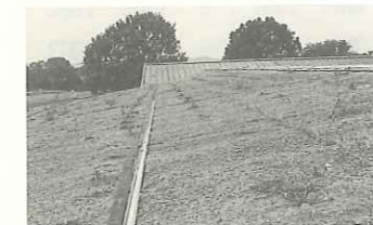
6月4日の牛舎屋根緑化の状況
