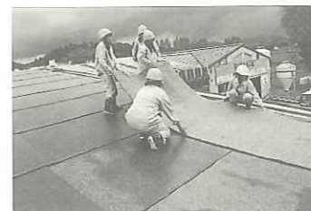
リフモボード(圧縮した古着繊維)の上に古着マットを2枚重ねる
