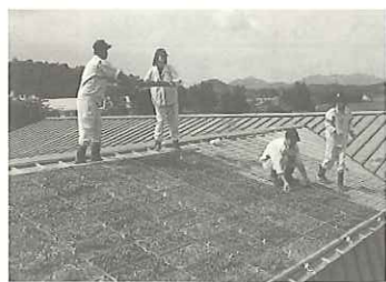
屋根緑化 (セダム)
