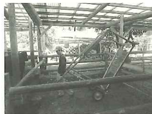
(写真3) 保定枠を牛舎に移動させるところ(1号機)
