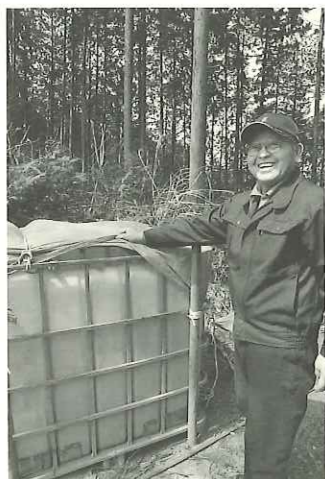
北原さんと給水マス。水が少なくなったらポンプが作動し、水が多くなったら停止する。
